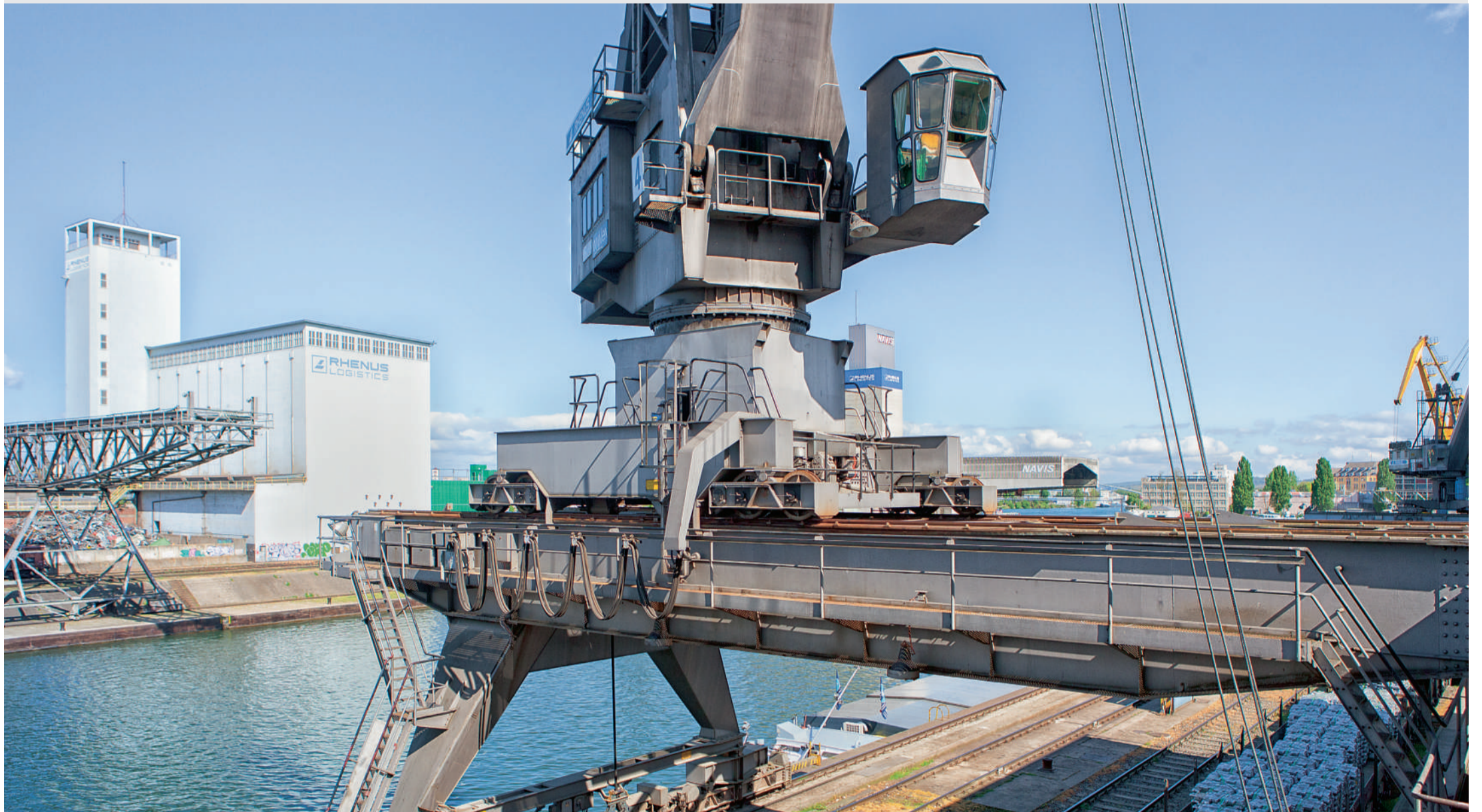
Die Rhenus Port Logistics AG bietet Umschlaglagerung und Transport von Massen- und Schüttgut an, beispielsweise Getreide und Reis. Das Unternehmen betreibt einen grossen Teil der Hafeninfrastuktur und prägt mit seinen Bauten das Bild des Basler Hafens im Dreiländereck.
